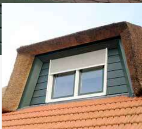
Gevelbekleding, boeiborden en dakrandpanelen
